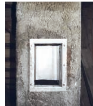
2. Einputzrahmen einmauern
