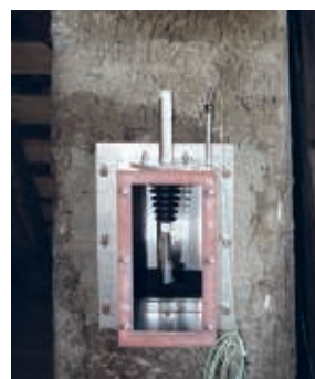
3. Abscheider an Einputzrahmen befestigen
