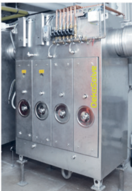
FilterBox 4 200 Alters- und Pflegeheim, Steck- born TG, Hackschnitzelfeuerung 240 kW - W40
