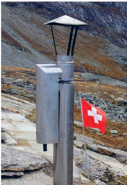
OekoTube Stückholz Einzelraumfeuerung (Cheminée), Berghütte, Saas-Fee VS, 2400 m.ü.M.
