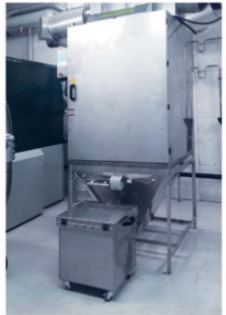
OekoRona 200 Krankenhaus, Lausanne VD, Pelletfeuerung 180 kW
